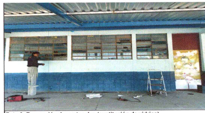
Foto 6: Reparación de ventanales (sustitución de vidrios)
