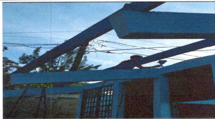
FOTO 2: Reparación de estructura del techo
