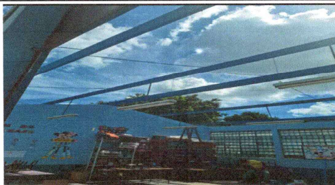
Foto 1: Sustitución y cubierta de lámina (calibre 26)
