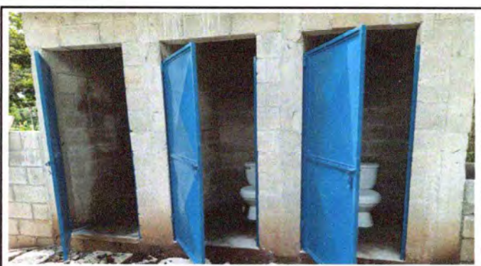
Foto 4: TASAS DE SANITARIOS Y PUERTAS INSTALADAS.
