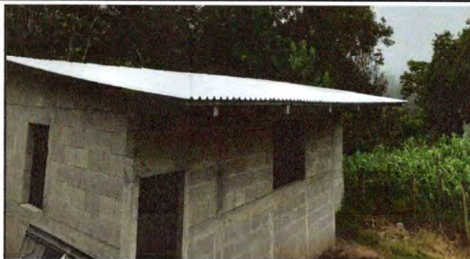
Foto1: PAREDES DE AULA COMPLETADAS
