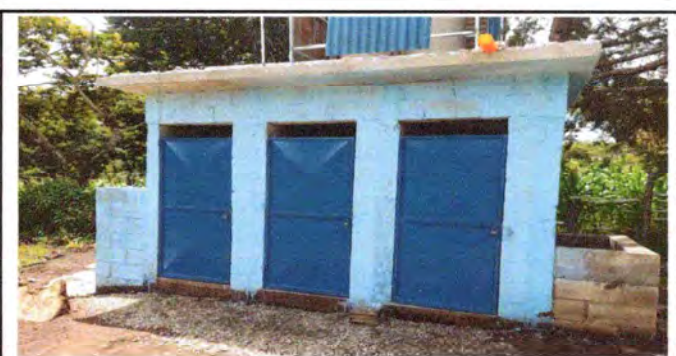
Foto 6: SANITARIOS TERMINADOS CON URINAL Y LAVAMANOS FUNDIDO
