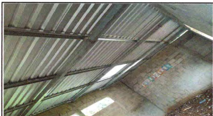
Foto 3: LAMINA Y ESTRUCTURA COMPLETADA
