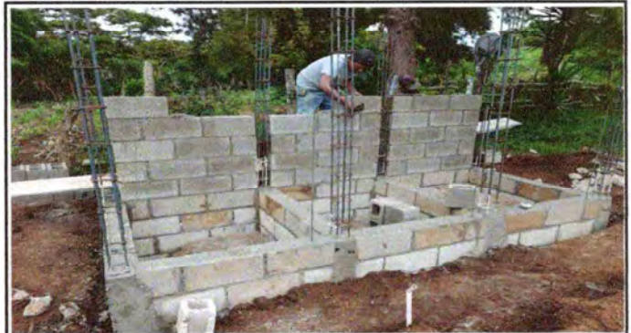
Foto 4: LEVANTADO DE PAREDES QUE SUSTITUYEN PAREDES EN MAL ESTADO EN SANITARIOS.
