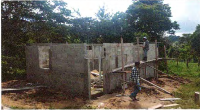
Foto1: LEVANTAMIENTO DE PAREDES DE AULA
