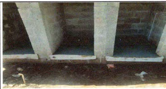
Foto 5: BASE PARA INSTALACIÓN DE SANITARIOS LISTO.
