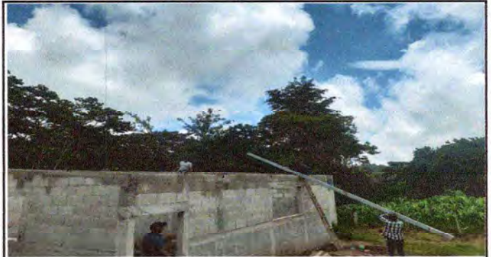
Foto 2: INSTALACION DE ESTRUCTURA PARA ANCLAJE DE LAMINA
