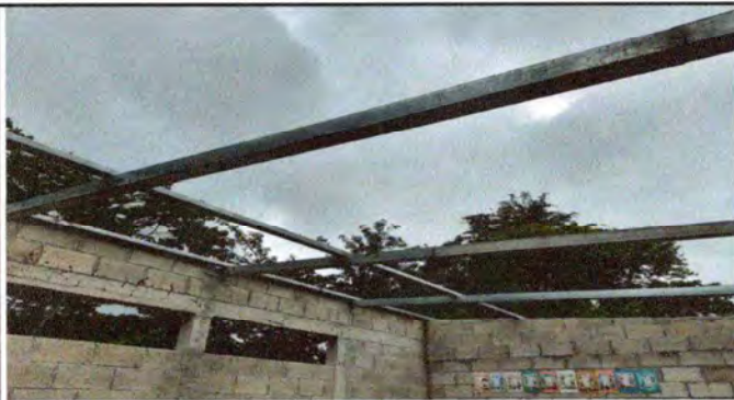
Foto 3: ESTRUCTURA LISTA PARA INSTALAR LAMINA TROQUELADA
