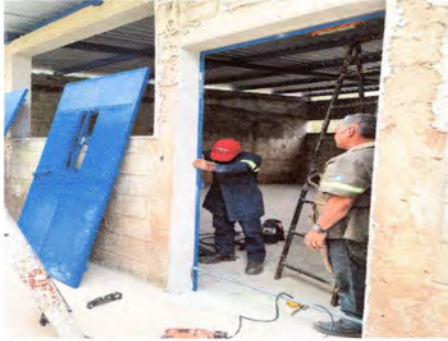
Foto1: cambio de puertas e instalación en proceso
