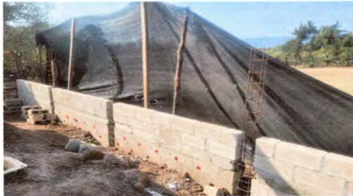
Foto: 5 Reparación del muro perimetral en proceso
