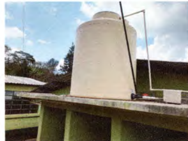
Foto: 6 Instalación del rotoplas en proceso
