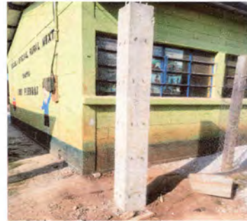
Foto4: columnas para instalar el portón en proceso
