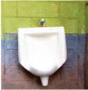
Foto3: cambio de mingitorio en proceso
