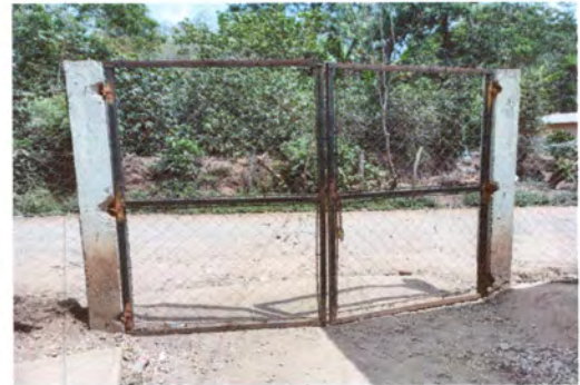
Foto4: El porton se puede apreciar que esta en mal estado.
