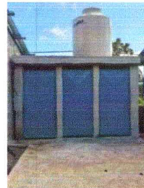
Foto 4: Sustrucción de cisterna (fosa séptica)
