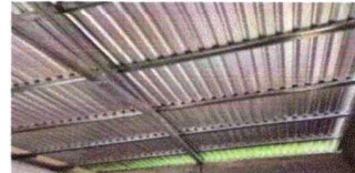
Estructura de techo
