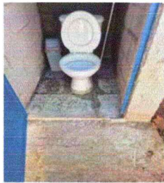
Foto 3: Sustrucción de baños
