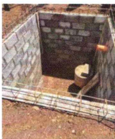
Foto 3: Sustituir de fosa septica
