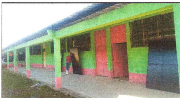
cambio de puertas
