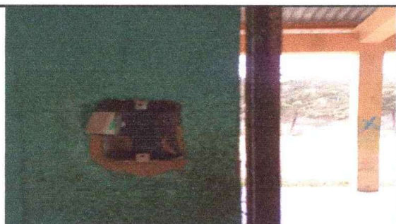
cambiando el cableado de la electricidad
