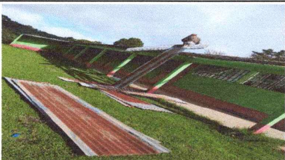
cambiando el techo
