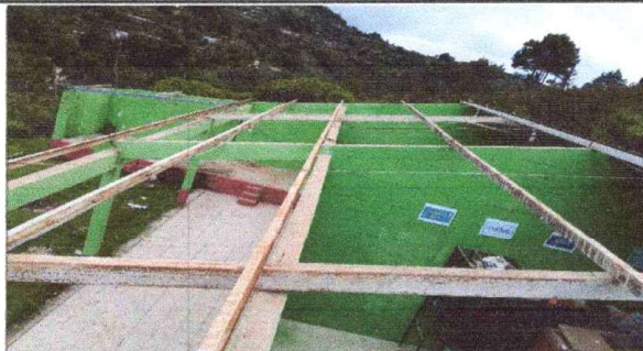
mantenimiento de costaneras
