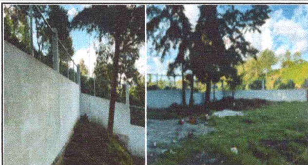
Foto 2: Muro perimetral parte interna terminada
