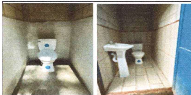
Foto 5: Servicios sanitarios y sus accesorios instalados
