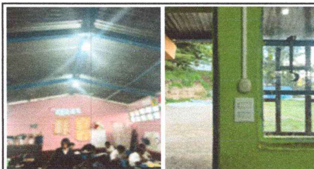
Foto 4: Instalación eléctrica terminada
