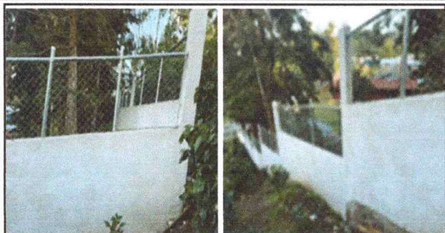
Foto1: Muro perimetral parte externa terminada
