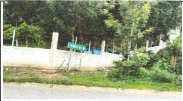
Foto 2: Avance muro perimetral parte externa
