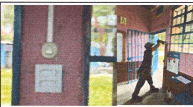
Foto 4: instalando tomacorrientes y apagadores
