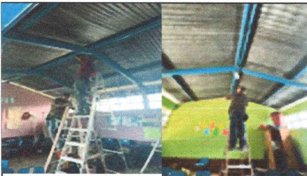
Foto 3: cambiando e instalando alambre para el alumbrado
