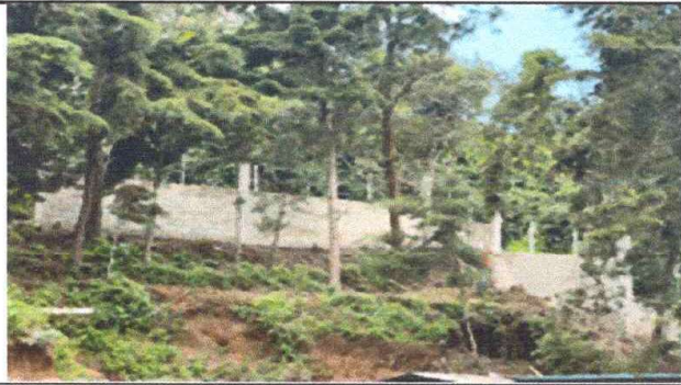
Foto 1: Avance muro Perimetral parte interna
