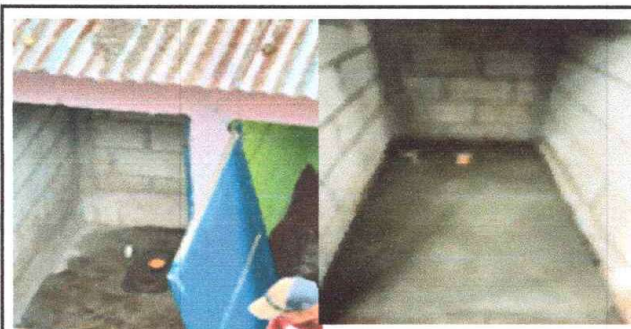
Foto 6: preparando instalación para nuevos baños
