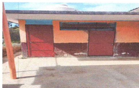
LOSA DE PATIO, PUERTAS Y VENTANAS NUEVAS
