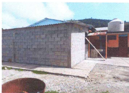
TINACO PARA GUARDAR AGUA, PUERTAS Y VENTANAS NUEVAS Y REPARADAS
