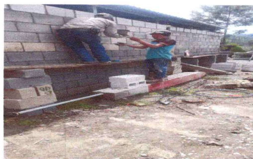
SUSTITUCION DE PAREDES
