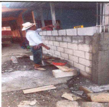
SUSTITUCION DE PAREDES
