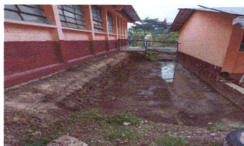
LIMPIEZA PARA FUNDICION DE LOSA DE PATIO, POSTERIORMENTE COLOCACION DE MESAS Y BANCAS PARA AREA RECREATIVA Y COMEDOR.
