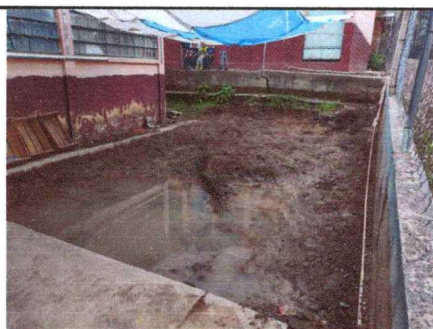
SUSTITUCION DE PLANCHAS DE LOSA DE PATIO EN AREA AULA DE PARVULOS Y FRENTE DE COCINA
