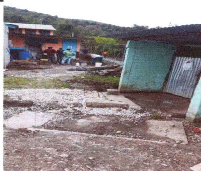
LOSA DE PATIO EN AREA DE SANITARIOS
