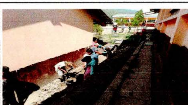
Foto 6: SUSTITUCIÓN DE LOSA DE PATIO POR FILTRACIONES
