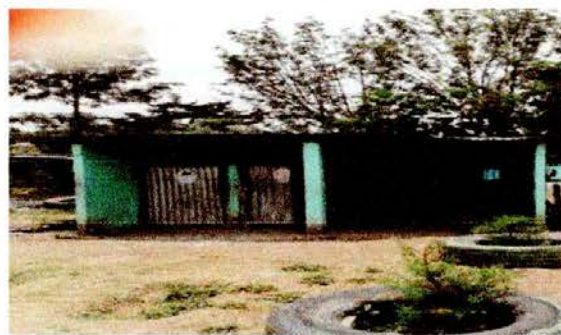
Foto 2: SUSTITUCIÓN DE PAREDES
