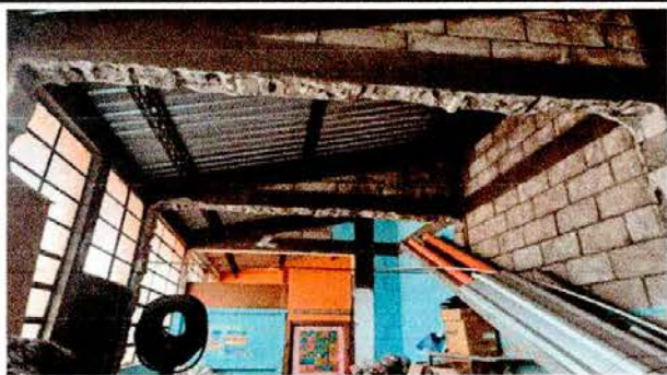
Foto 3: REPARACIÓN DE PAREDES Y LOSA PARA SUSTITUCIÓN DE ÁREA DE COCINA
