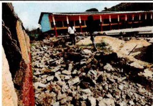
Foto 1: SUSTITUCIÓN DE LOSA DE PATIO (YA SE DEMOLIÓ)
