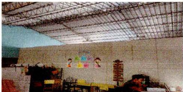
Foto1: REPOSICION DE PAREDES
