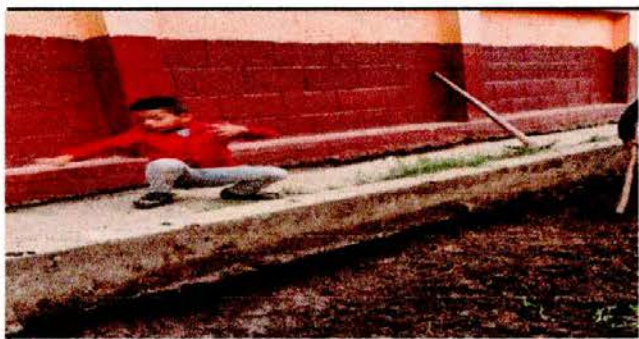
Foto 5: SUSTITUCIÓN DE PAREDES
