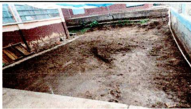
Foto 4: FUNDICIÓN DE LOSA DE PATIO POR INUNDACIÓN
