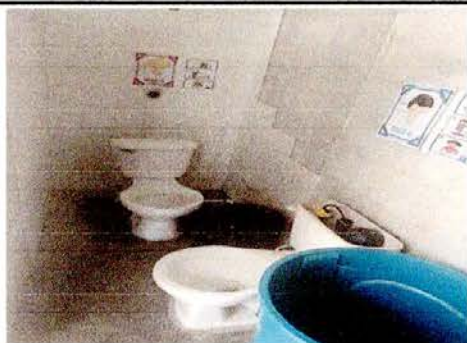
Foto 3: REPOSICION DE SANITARIO
