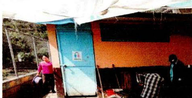
Foto 2: SUSTITUCIÓN DE PUERTAS DE SANITARIOS
