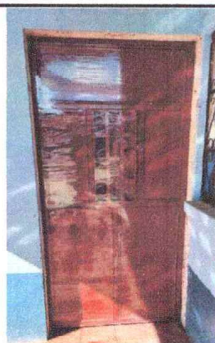
Foto 1: Puerta nueva en área de bodega
