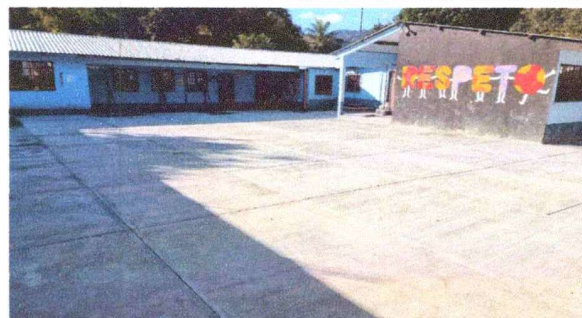
Foto 4: Losa de patio nueva
