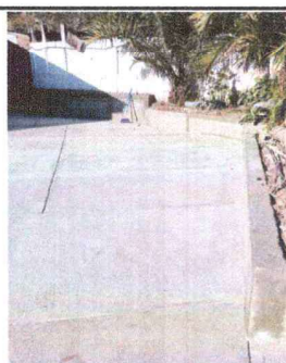
Foto 5: Reparación de jardinera
