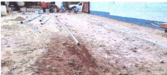
Foto 5: Preparación del suelo para fundición de losa de patio
