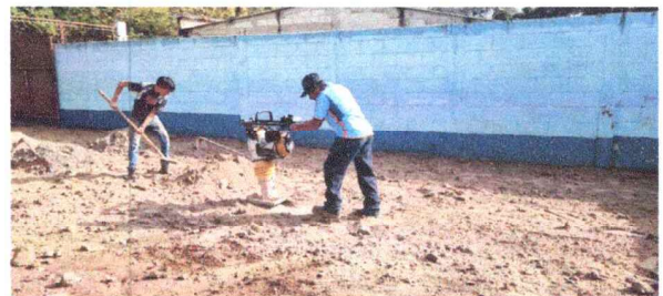
Foto 4: Preparación del suelo para fundición de losa de patio
