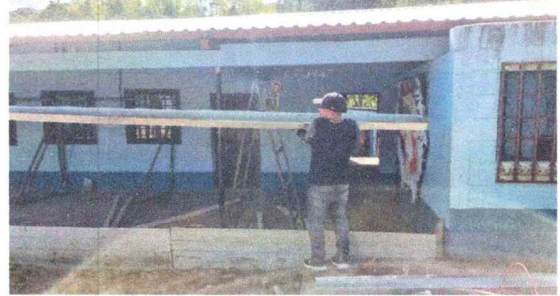
Foto 2: Desinstalación de canal y bajada de agua pluvial
