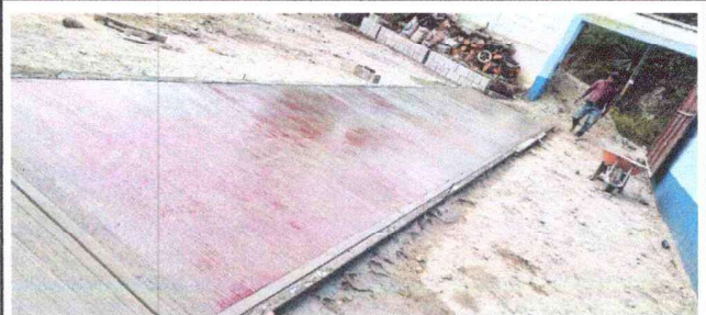
Foto 6: Fundición de losa de patio
