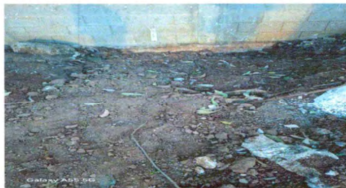
Foto 4: Reparacion de red de drenaje y red de agua potable (fosa mas tuberia)
