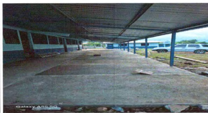
Foto 5: Losa de patio
