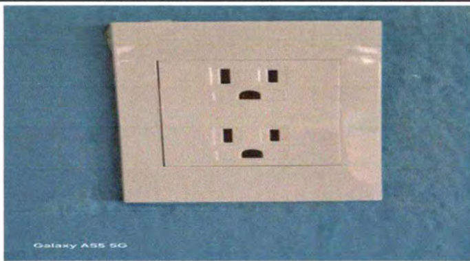
FOTO 8: instalacion de tomacorrientes
