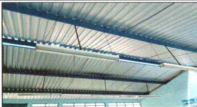
Foto 1: Sustitución y cubierta de lámina (calibre 26)
