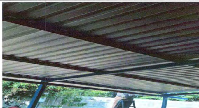
FOTO 2: Estructura del techo
