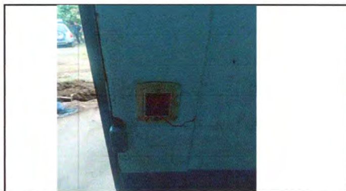
Foto 10: instalacion de interruptores
