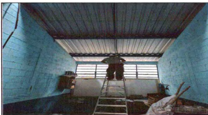
Foto 9: instalacion de lamparas
