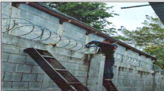
Foto 7: Reparacion de razor ribbon
