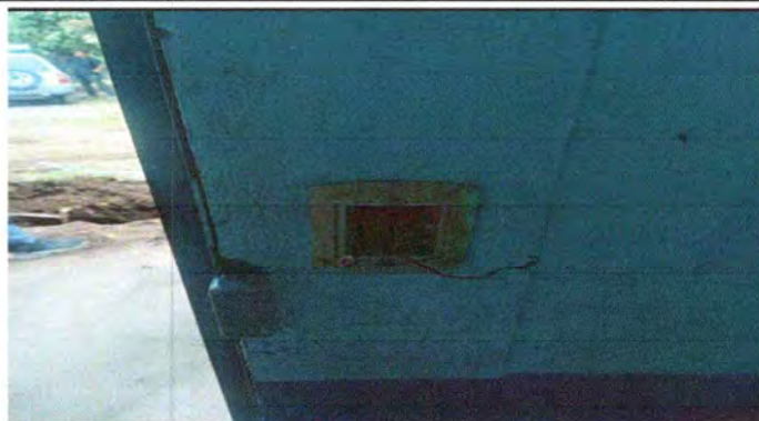
FOTO 8: instalacion de tomacorrientes
