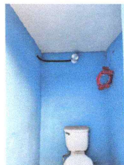
Foto 2: Reparación de Servicios Sanitarios y sus accesorios
