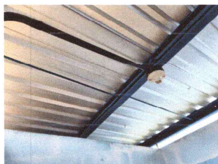
Foto 4: Estructura de Techo (Galvanizada)
