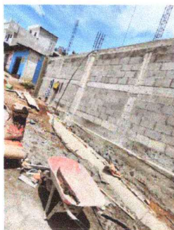
Foto 1: . Reparación de Muro de Contención
