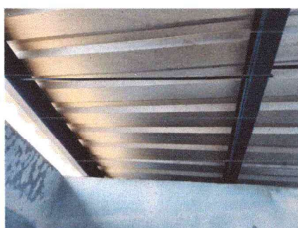
Foto 5: Cubierta de Lamina (Aluzinc C26)
