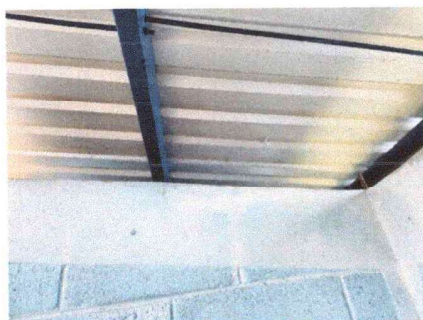
Foto 5: Cubierta de Lamina (Aluzinc C26)
