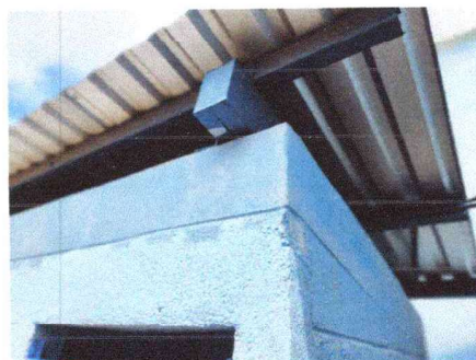
Foto 4: Estructura de Techo (Galvanizada)
