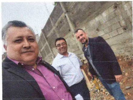
Foto1: . Reparacion de Muro de Contención
