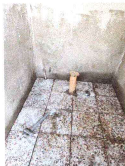
Foto 2: Reparación de Servicios Sanitarios y sus accesorios
