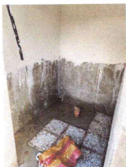
Foto 3: Reparación de red de drenajes
