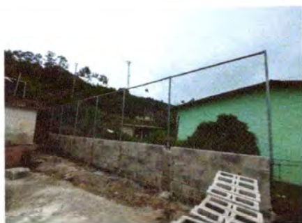
Foto3: MURO PERIMETRAL DE BLOCK (reforzado con zapatas, columnas y vigas.)
