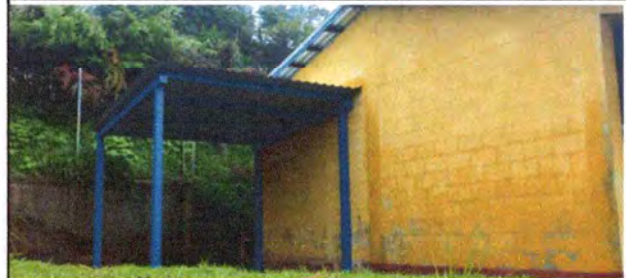
FOTO 8: CUBIERTA DE TECHO (desmontaje e instalacion de lamina troquelada calibre 26)
