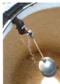
Foto 5: REPARACION Y MANTENIMIENTO A DEPOSITO DE AGUA
