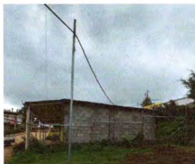
FOTO 2: MURO PERIMETRAL (malla galvanizada, tubo galvanizado)
