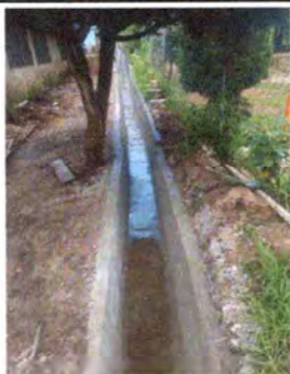
Foto1: CUNETA DE CONCRETO (0.50 * 0.30 CMS)
