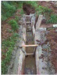
Foto1: CUNETA DE CONCRETO (0.50 * 0.30 CMS)
