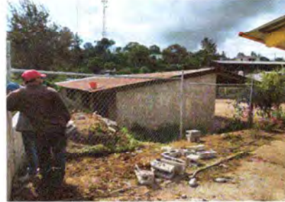
FOTO 2: MURO PERIMETRAL (malla galvanizada, tubo galvanizado)
