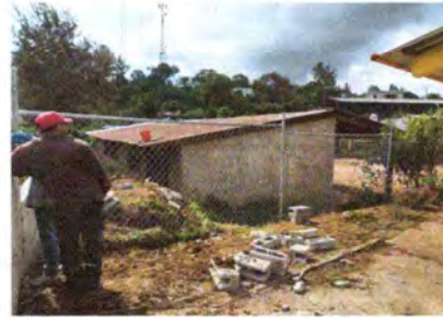
FOTO 2: MURO PERIMETRAL (malla galvanizada, tubo galvanizado)
