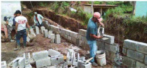
Foto3: MURO PERIMETRAL DE BLOCK (reforzado con zapatas, columnas y vigas.)
