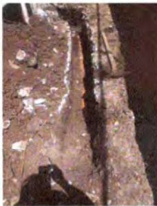
Foto5: REPARACION DE SISTEMA DE DRENAJE Y RED DE AGUA POTABLE
