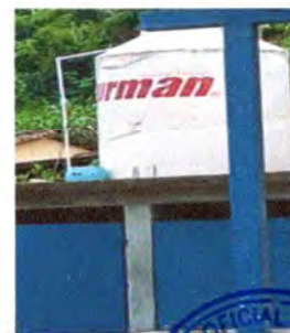
Foto 6: REPARACION Y MANTENIMIENTO A DEPOSITO DE AGUA
