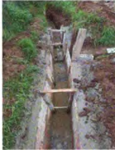
Foto1: CUNETA DE CONCRETO (0.50 * 0.30 CMS)
