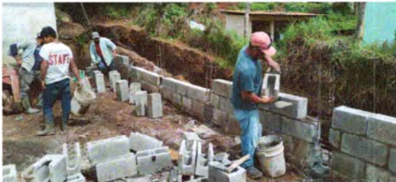
Foto3: MURO PERIMETRAL DE BLOCK (reforzado con zapatas, columnas y vigas.)
