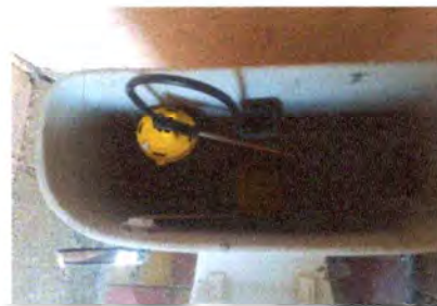
Foto4: SERVICIOS SANITARIOS (sustitucion de accesorios,)
