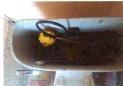
Foto4: SERVICIOS SANITARIOS (sustitución de accesorios,)
