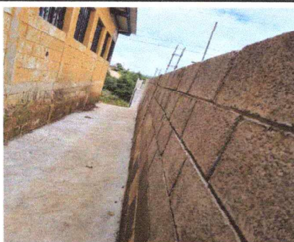
Foto 3: LOSA DE PATIO
