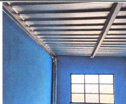
Foto 4: ESTRUCTURA DE TECHO Y CUBIERTA DE LÁMINA
