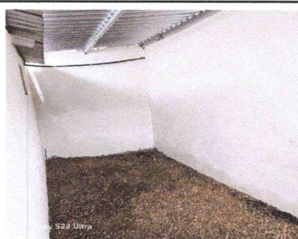
Foto 4: ESTRUCTURA DE TECHO Y CUBIERTA DE LÁMINA
