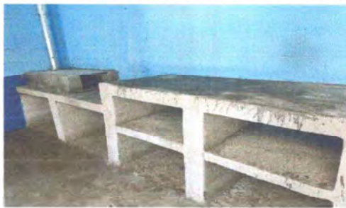
Foto 9: REPARACIÓN O SUSTITUCIÓN DE AREA DE COCINA (ESTUFAS RURALES, PILAS, VENTANAS, PUERTAS, CHIMENEA, ETC)
