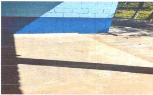
Foto 7: LOSA DE PATIO
