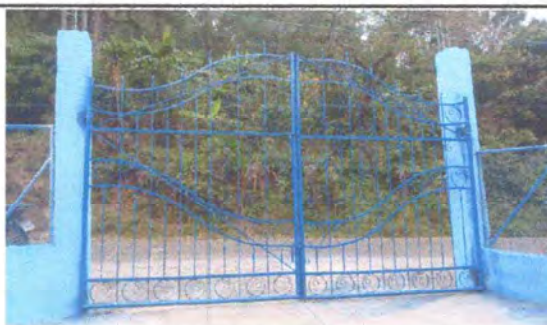
Foto 4: REPARACIÓN Y MANTENIMIENTO DE PORTÓN TERMINADO
