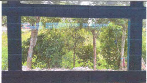
Foto 1: SUSTITUCIÓN DE VIDRIOS MEDIDAS TÍPICAS FINALIZADO
