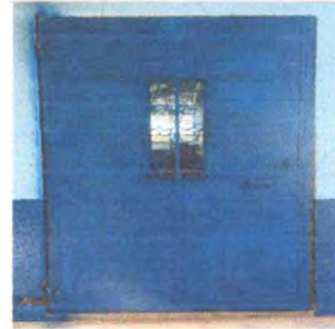
Foto 8: REPARACIÓN Y MANTENIMIENTO DE PUERTAS FINALIZADO
