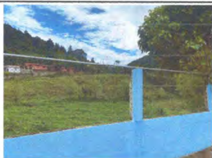
Foto 5: SUSTITUCIÓN DE MURO PERIMETRAL CON BLOCK Y MALLA TERMINADO
