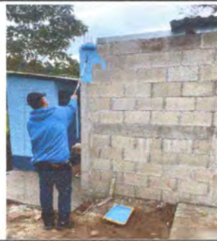
Foto 2: SUSTITUCIÓN DE PINTURA BASE AGUA
