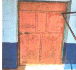
Foto 8: REPARACIÓN Y MANTENIMIENTO DE PUERTAS
