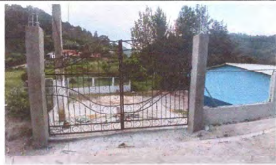
Foto 4: REPARACIÓN Y MANTENIMIENTO DE PORTÓN
