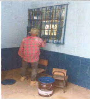
Foto 3: SUSTITUCIÓN DE PINTURA DE ACEITE
