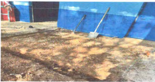
Foto7: LOSA DE PATIO EN MANTENIMIENTO
