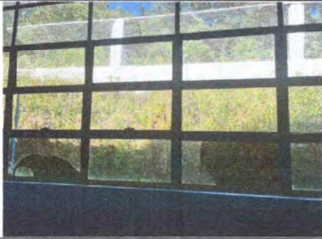
Foto 1: SUSTITUCIÓN DE VIDRIOS MEDIDAS TÍPICAS
