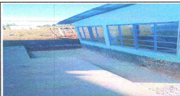
Foto 6: Sustitucion de vidrios quebrados.
