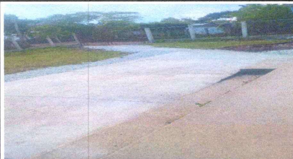
Foto 2: Sustitucion losa de patio.
