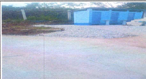
Foto 4: Sustitucion de sanitarios.
