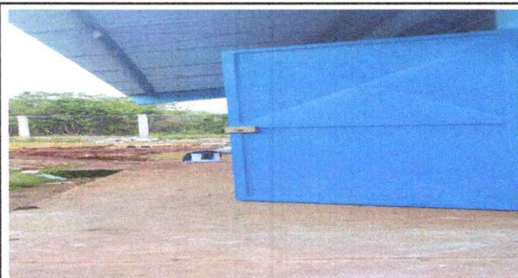
Foto 3: reparacion y mantenimiento de puertas.
