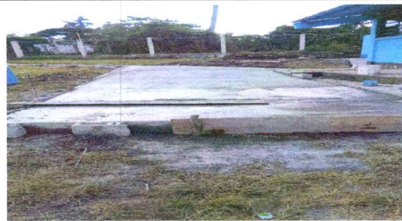
Foto 2: Sustitución losa de patio.
