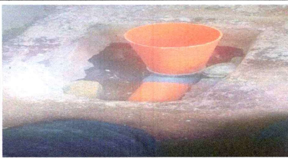
Foto 1: Reparación y mantenimiento de sanitario.
