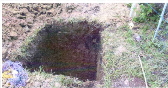
Foto 5: Sustitución de red de drenaje pvc.
