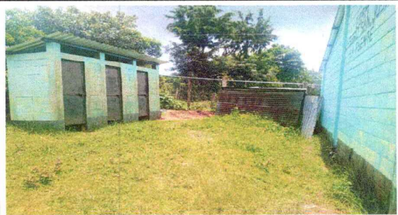
Foto 4: Sustitución de sanitarios.
