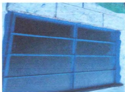
Foto 7:reparación de ventana y cambio de vidrios finalizado
