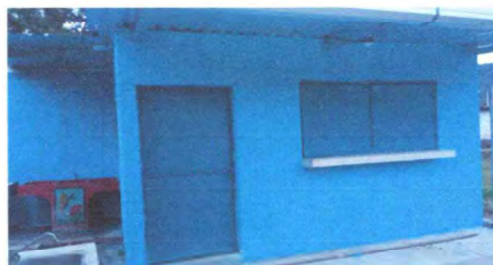
Foto 12: reparación del sistema eléctrico. Finalizado
