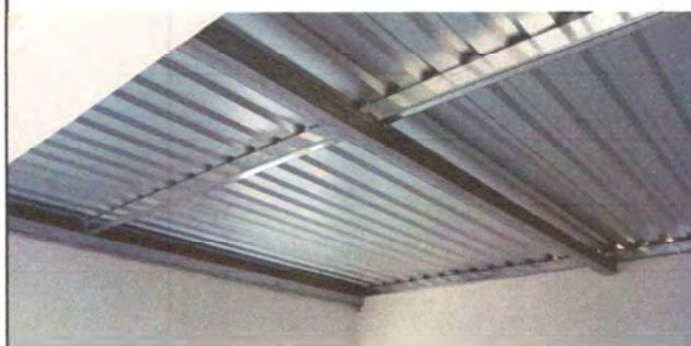
Foto 6: cambio de cubierta de lámina finalizado
