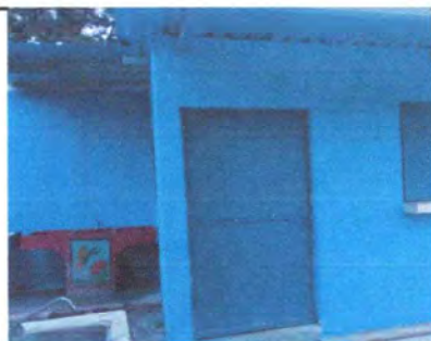
Foto 9: mantenimiento a puerta de metal cambio de chapa , pintado finalizado
