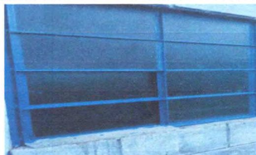
Foto 8: reparación de ventanana y reposición de vidrios finalizado
