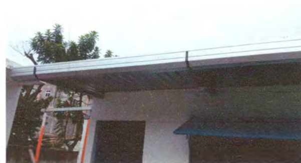
Foto 14: reparación de canal finalizado
