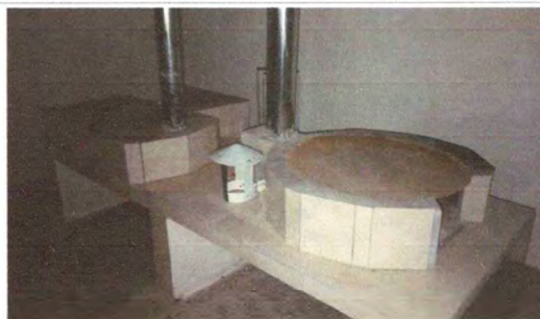
Foto 2. area de cocina, instalacion de plancha de metal finalizado
