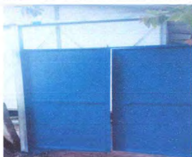
Foto 15: mantenimiento a porton de metal finalizado
