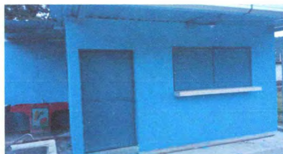
Foto 10: repello en exterior finalizado
