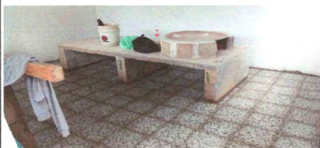
foto 3: Reparación del área de piso de la cocina finalizado
