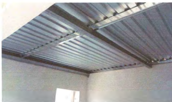
Foto 11, repello en interior de la cocina finalizado
