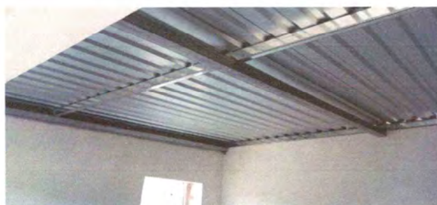
Foto 5: cambio de estructura del techo finalizado
