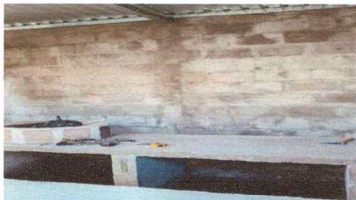
Foto 1: reparación de pollo de fuego para colocar plancha de metal y comal en proceso
