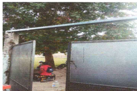
Foto 6: Reparación de portón de metal en proceso
