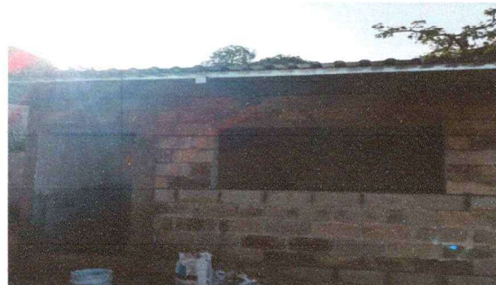
Foto 2: trabajos en el área de la cocina en proceso
