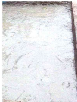
Foto 3: reparación de cuneta de concreto en proceso
