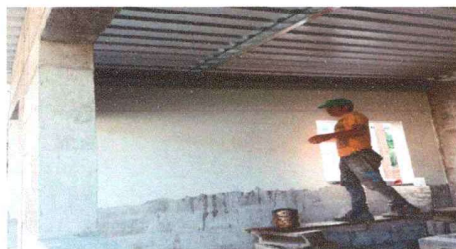
Foto 5: trabajos de repello en cocina en proceso
