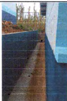
Foto 1: Muro de contención culminado.
