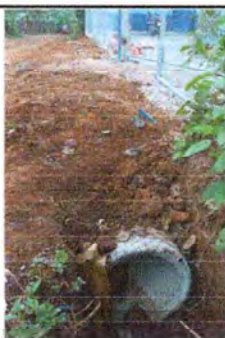
Foto 5: Tubos para paso de agua de lluvia colocados y en funcionamiento
