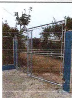
Foto 2: Portón de malla con tubos terminado y colocado.
