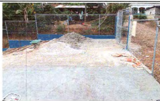
Foto 4: Culminación de la reparación de losa de patio
