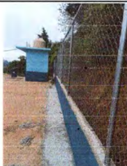
Foto 3: Muro perimetral restaurado y finalizado
