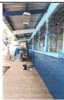
Foto 6: Aplicación de pintura en muro perimetral, muro de contención, baños y paredes exteriores de aulas completada.
