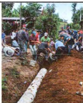
Foto 5: Reparación de drenaje de aguas pluviales
