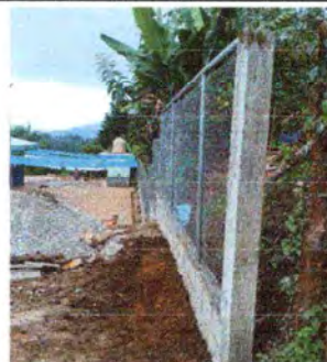
Foto 2: Reparación de columnas para la instalación de portón de malla
