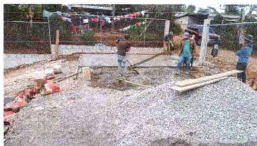
Foto 4: Fundición de losa de patio
