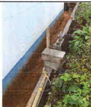
Foto 1: Reconstrucción de muro de contención
