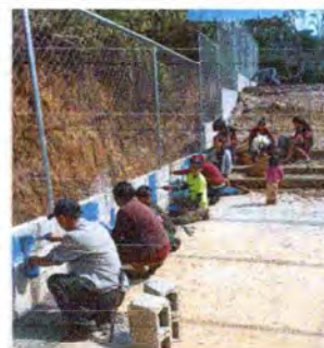
Foto 6: Aplicación de pintura en muro perimetral, muro de contención, baños y paredes exteriores de las aulas
