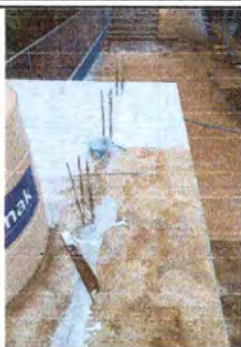
Foto 7: Aplicación de impermeabilizante para terraza de baño.
