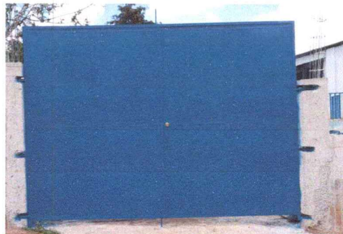
Foto 2: REPOSICIÓN DE PORTÓN
