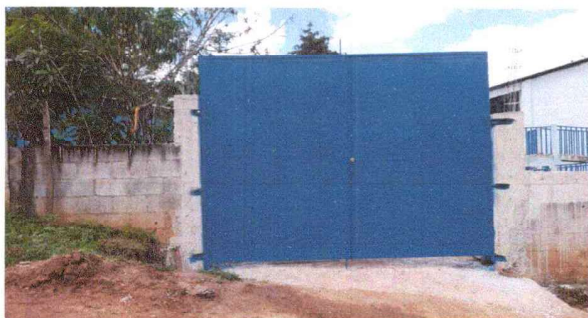
Foto1: REPOSICIÓN DE PORTÓN
