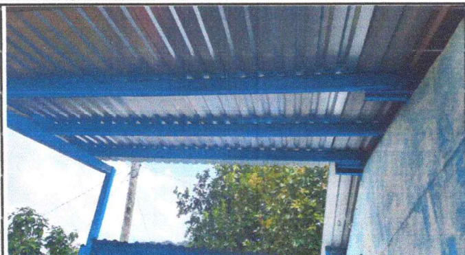
Foto 1: Sustrucción de lamina troquelada
