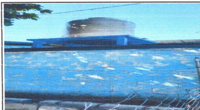
Foto 3: Instalación de tinaco mas base
