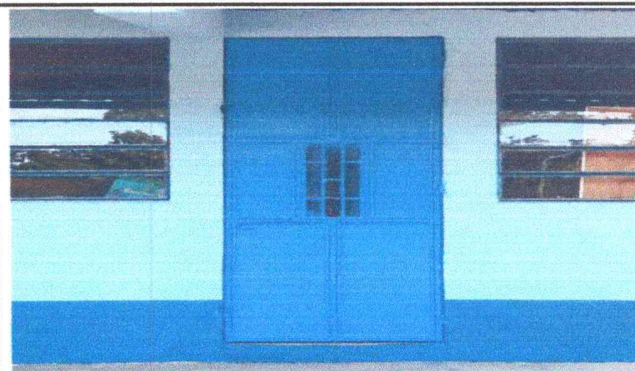
Foto 2: Puertas reparadas y pintadas
