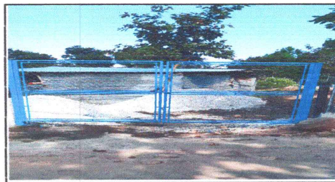
Foto 6: Porton reparado y pintado
