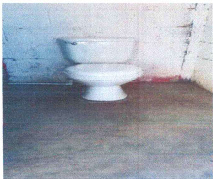
Foto1: Sustitución de servicio sanitarios
