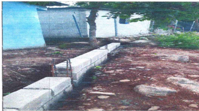
Foto 4: Sustitución de malla
