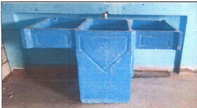
Foto 3: cambio de pila
