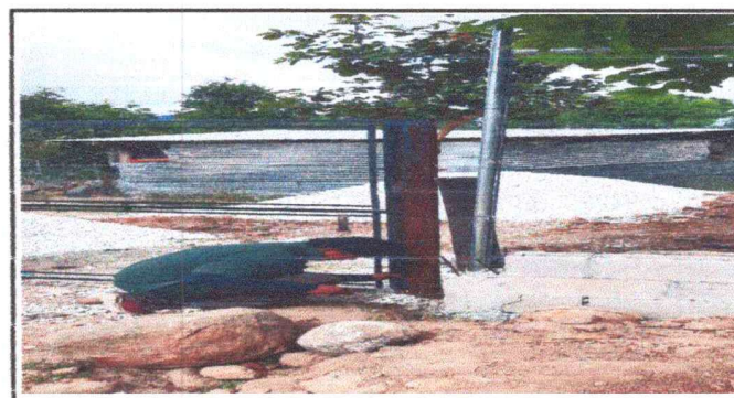
Foto 6: Reparación del porton
