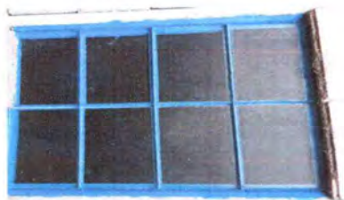
Foto 5: Sustrucción de ventana
