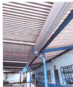
FOTO 2: Sustrucción de canal en buen estado
