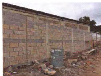
Foto 6: Sustrucción de muro perimetral
