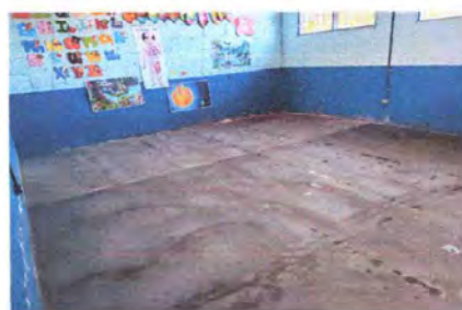
Foto4: Sustrucción de piso de cemento
