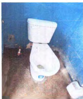
Foto 7: Sustitución de baños
