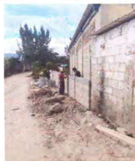
Foto 6: Sustrucción de muro perimetral
