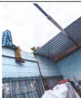
Foto1: Sustrucción de Lamina en buen estado
