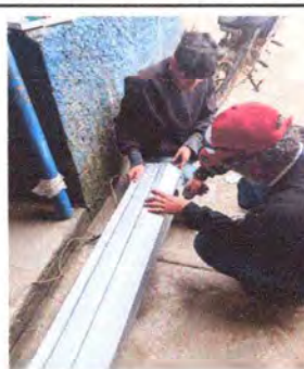
FOTO 2: Sustrucción de canal en buen estado
