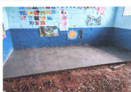
Foto4: Sustrucción de piso de cemento
