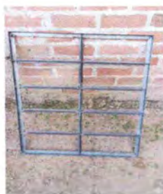
Foto 5: Sustrucción de Ventana
