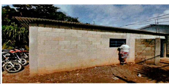
reparacion de paredes
