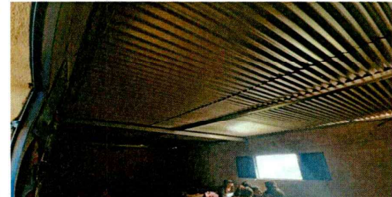
cambio de estructura metalica
