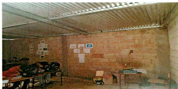
reparacion de torta de concreto
