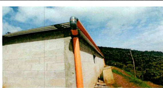
colocacion de canales
