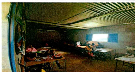
cambio de techo de laminas
