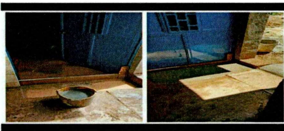
reparacion de torta de concreto
