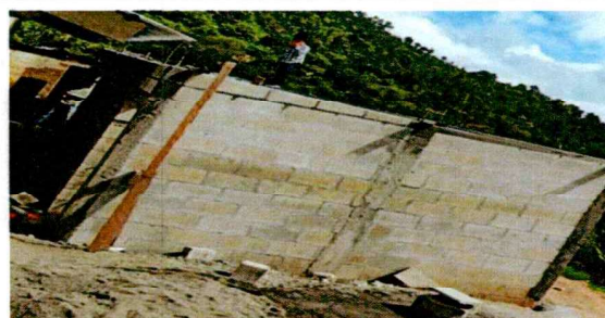
reparacion de muros
