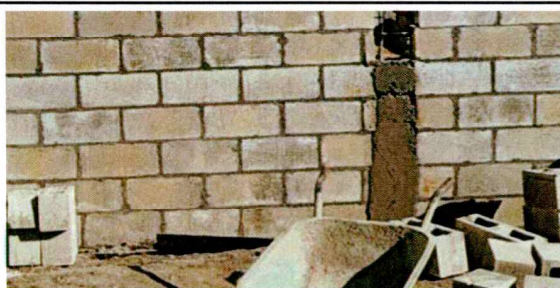
reparacion de muros
