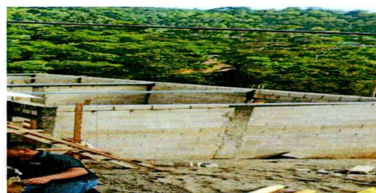
Foto 2: Reforzamiento de la estructura y cambio de la cubierta de lamina
