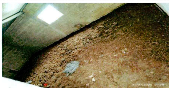
reparacion de torta de concreto
