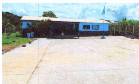
Foto 2: Se observa la reparación de la losa del patio en su totalidad.
