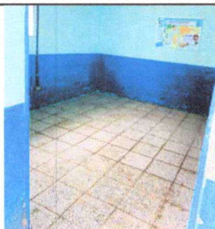
Foto 6: Se muestra la instalación finalizada del piso de granito.
