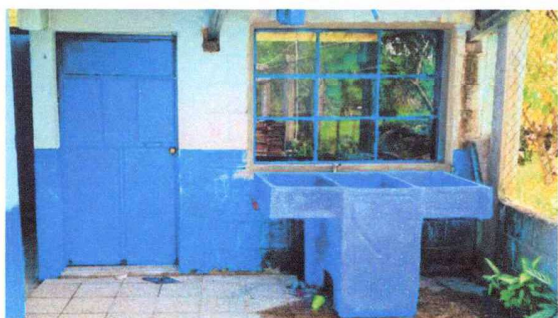
Foto 1: Se evidencia la reparación de la ventana de la cocina.
