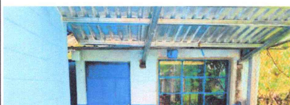
Foto 5: Instalación de lámina troquelada y estructura de metal.
