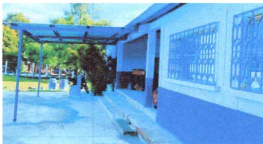
Foto 4: Se evidencia la aplicación de la pintura.
