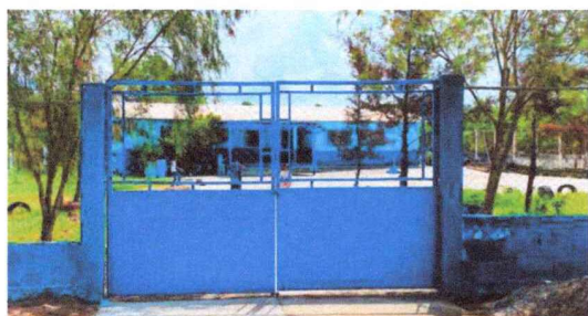
Foto 3: Se muestra la instalación finalizada del portón de ingreso a la escuela.
