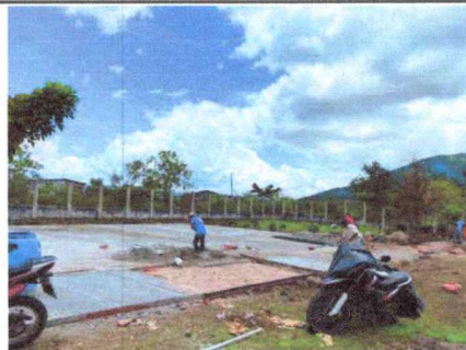
Foto 2: Avance significativo en la reparación de la losa del patio.
