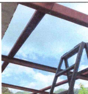
Foto 5: Se observa el avance en la instalación de estructura y lámina.
