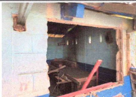
Foto 1: La reparación de la ventana, en proceso.
