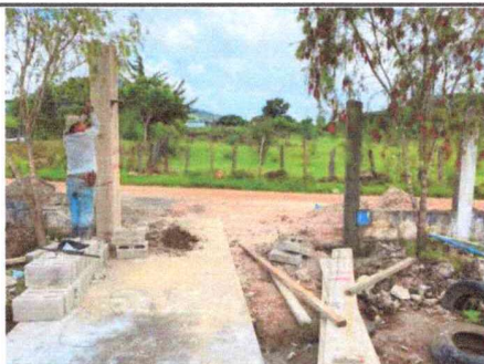
Foto 3: Se realizan los ajustes para la próxima instalación del portón.
