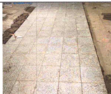
Foto 6: Avance en la instalación de piso de granito.
