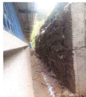
Foto 2: Se Construyo de muro de contención, para evitar alto riesgo por deslave
