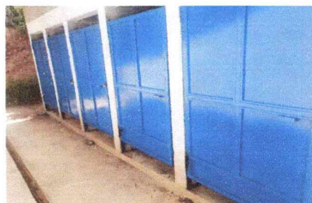
Foto 4: Se repararon puertas de baño
