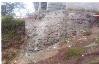
Foto 3: Se construyo muro de contención por deslave para el uso de los baños y evitar riesgos
