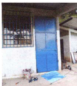
Foto 5: Se reparon puertas de Aulas
