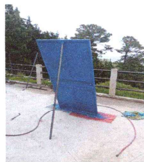
Foto 4: Se reparaon puertas en mal Estado
