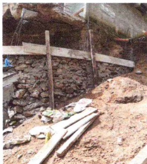
Foto 3: Construccion de muro de contención por deslave, el cual que es necesario para tener uso de los baños y evitar riesgos
