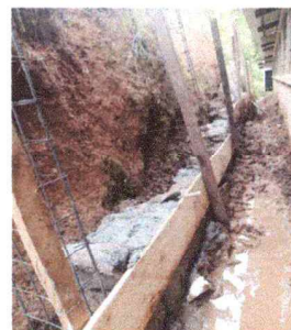
Foto 2: construccion de muro de contención, para evitar alto riesgo por deslave
