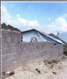
Foto: 5 CERCO O MURO PERIMETRAL
