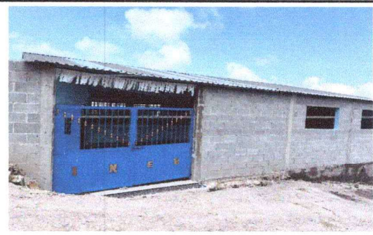
Foto4: MANTENIMIENTO DE PORTONES
