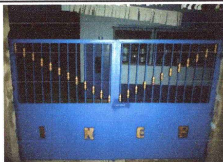
Foto4: MANTENIMIENTO DE PORTONES
