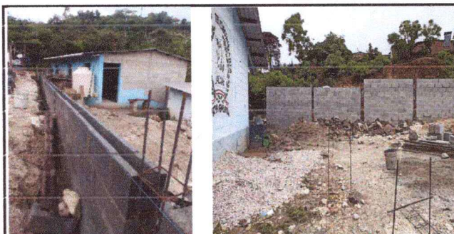
Foto: 5 CERCO O MURO PERIMETRAL
