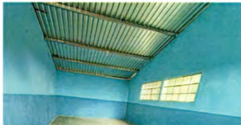
Foto 2: Cubierta de Lamina
