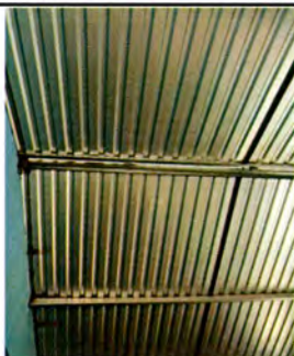
Foto1: Suministro e instalación de lamina troquelada Aluzinc Calibre 26 (incluye tornillos, capote)
