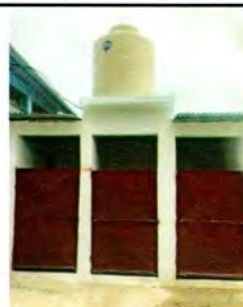
Foto 6: Reposición de ambiente de baños
