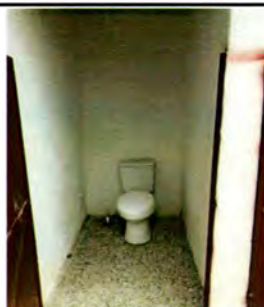
Foto 5: Instalación de baños
