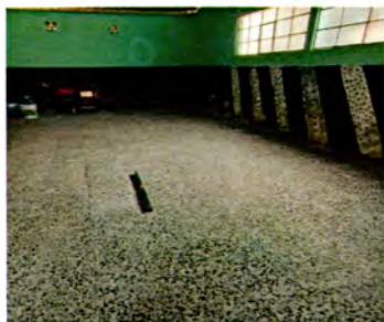
Foto 3: Suministro e instalación de piso de granito, Base para piso (plataforma)
