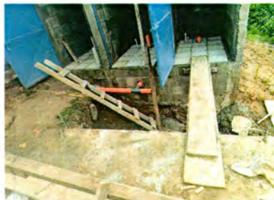
Foto 4: Reposición de Ambiente (Baños)
