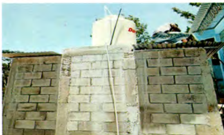
Foto 5: Sustitución de tinaco de 1100 litros incluye linea de distribución de agua y accesorios.
