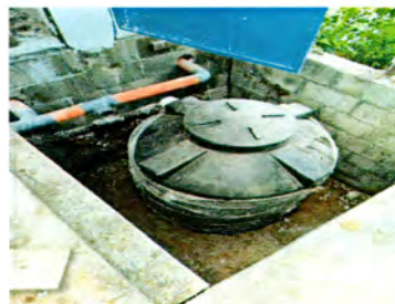
Foto 6: Sistema de drenaje de fosa séptica (Biodigestor plastico) mas pozo de absorción (tradicional)
