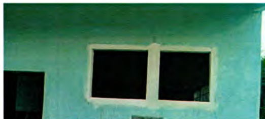
Foto 2: Reparación de Ventana marcos de metal 2.00x1.00 Incluye Vidrios
