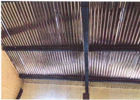
Foto 1: Cubierta de lamina
