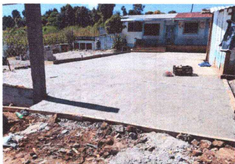
Foto 5: losa de patio
