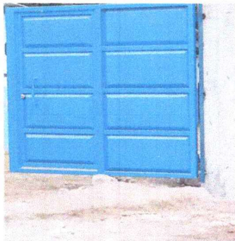
Foto 3: Mantenimiento a portones
