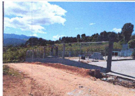
Foto 4: Cerco o muro perimetral
