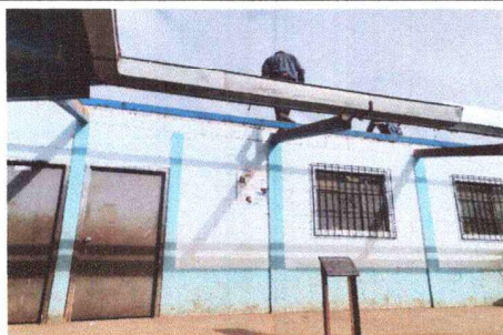
Foto1: Cubierta de Lamina
