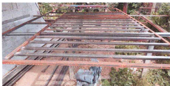
Foto 3: Mantenimiento de portones
