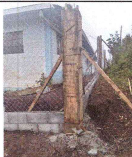
Foto 4: Cerco o muro Perimetral
