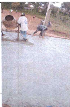
Foto 5: Losa de Patio
