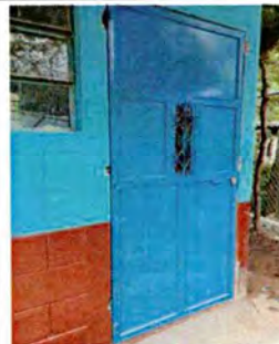
Foto 6: SUSTITUCIÓN DE PUERTAS DE AULAS FINALIZADO
