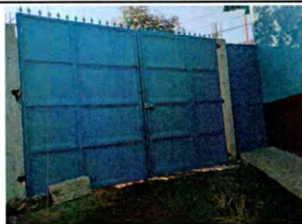
Foto 4: MEJORA DE PORTÓN FINALIZADO
