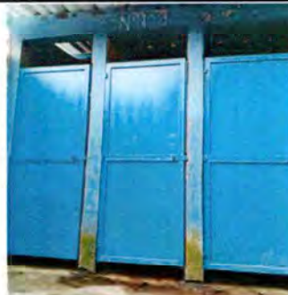
Foto 2: SUSTITUCIÓN DE PUERTAS DE BAÑOS FINALIZADO
