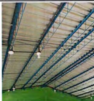
Foto 1: REPARACIÓN DE SISTEMA ELECTRICO FINALIZADO
