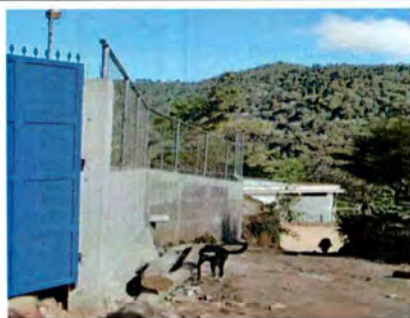
Foto 3: REPARACIÓN DE MURO PERIMETRAL FINALIZADO
