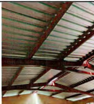
Foto1: REPARACIÓN DE TECHO Y ESTRUCTURA FINALIZADO
