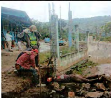
Foto 3: REPARACIÓN DE MURO PERIMETRAL
