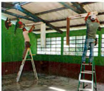
Foto1: REPARACIÓN DE SISTEMA ELECTRICO
