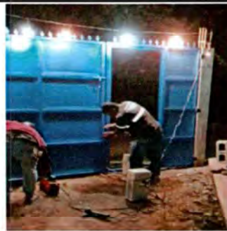
Foto 4: REPARACIÓN DE PORTÓN EN MAL ESTADO
