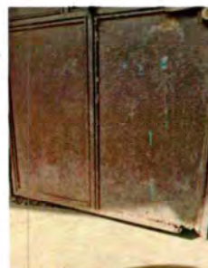
Foto 6: REPARACIÓN DE PUERTAS DE AULAS EN MAL ESTADO
