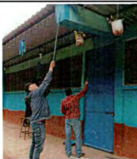
Foto 5: PINTURA DE ESTABLECIMIENTO DETERIORADO
