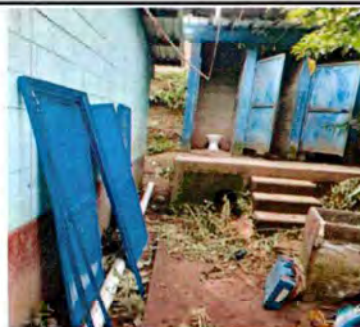
Foto 2: SUSTITUCIÓN DE PUERTAS DE BAÑOS
